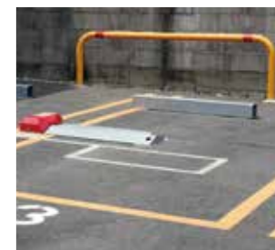
ライン工事・タイヤ止め
